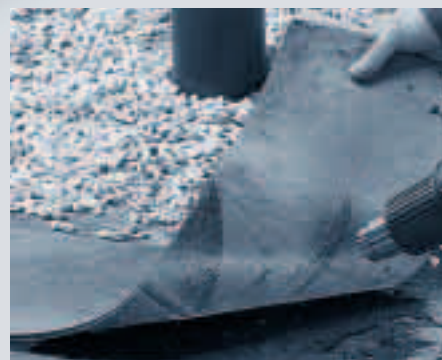
Schweißen von Dachpappe
